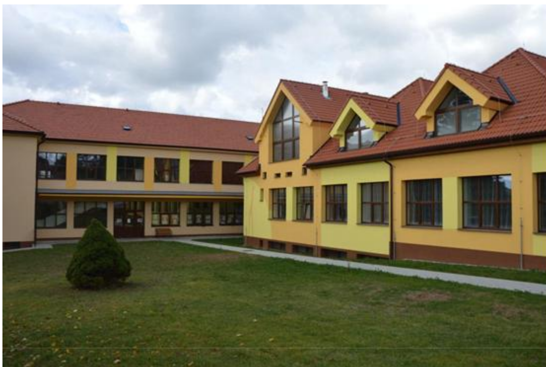
Obrázek č. 2 : Základní a mateřská škola V Louňovicích pod Blánkem
