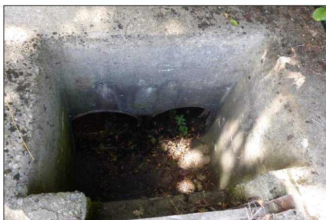
Propustek 16c - staničení 0,130 - pohled zleva
