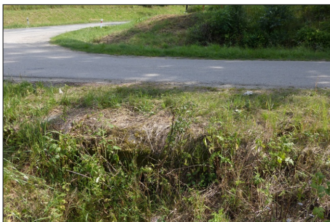
Propustek 33c - staničení 0,015 - pohled zprava
