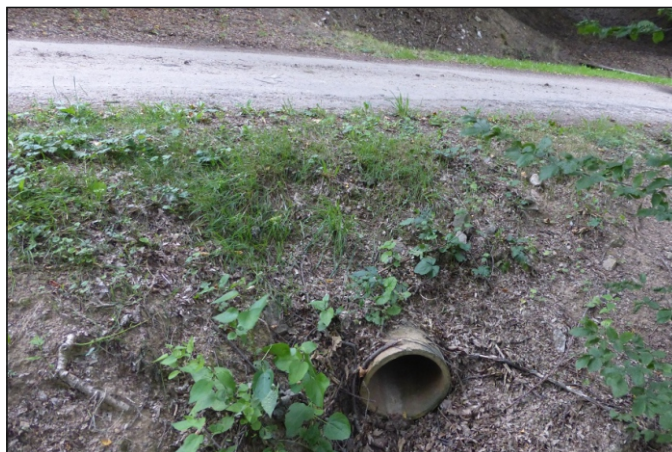
Propustek 31c - staničení 0,311 - pohled zprava
