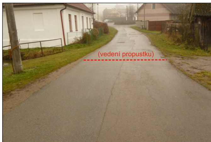
Propustek 1c - staničení 0,288 - celkový pohled
