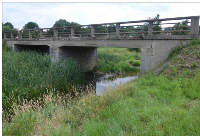
Most 30c-M1 - staničení 0,220 - pohled zleva
