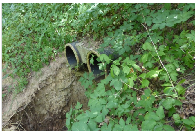
Propustek 16c - staničení 0,130 - pohled zprava
