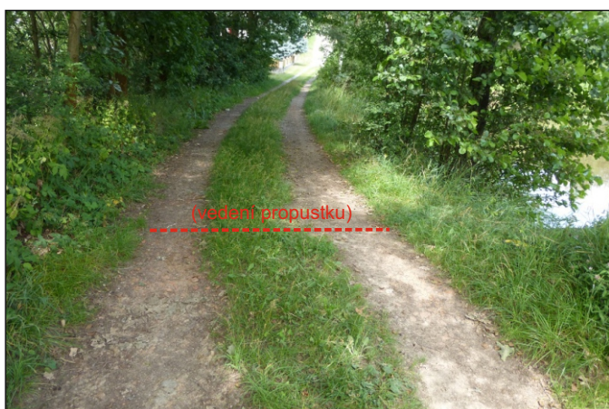
Propustek 16c - staničení 0,130 - celkový pohled
