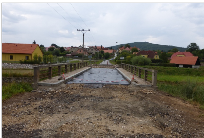
Most 30c-M1 - staničení 0,220 - celkový pohled
