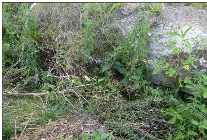
Propustek 33c - staničení 0,015 - pohled zleva
