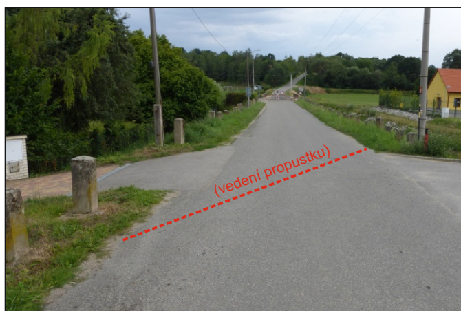
Propustek 28c - staničení 0,119 - celkový pohled
