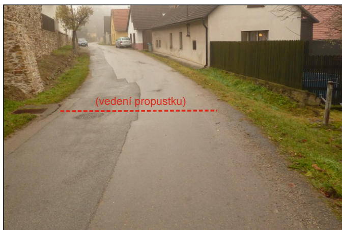
Propustek 1c - staničení 0,143 - celkový pohled
