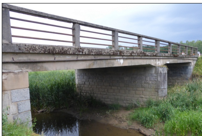
Most 30c-M1 - staničení 0,220 - pohled zprava
