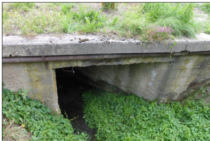
Propustek 28c - staničení 0,119 - pohled zleva
