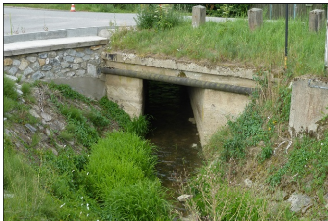
Propustek 28c - staničení 0,119 - pohled zprava
