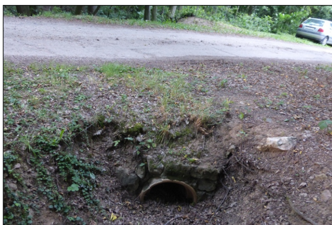
Propustek 31c - staničení 0,311 - pohled zleva
